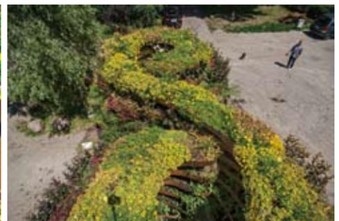
由Adam Kalinowski 設計的“THE INFINITE GREEN”看起來就像是一個綠色雕塑。它由不銹鋼、木質的結構所組成，上面有著以泥土種植的植物。這個雕塑從鳥瞰的角度看來，有著明顯的圖形符號。參觀者能夠進入雕像的内部空間去感受空間感，而在110米平方大小、共7層的雕塑之中，許多不同種類植栽的色彩，讓不同的綠色系在光影下顯現出豐富的層次。這些植物開花的時間在一年之間的不同時間，其中也有終年不斷生長的100種（全部約3000種植物）植物。供水系統在一天中，會以自動化澆水系統澆灌4次，而雕塑的每一層都配置了自動澆水系統。
